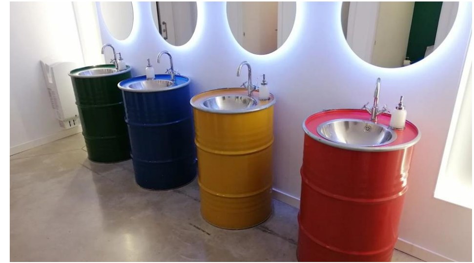
Barils transformés en lavabos
