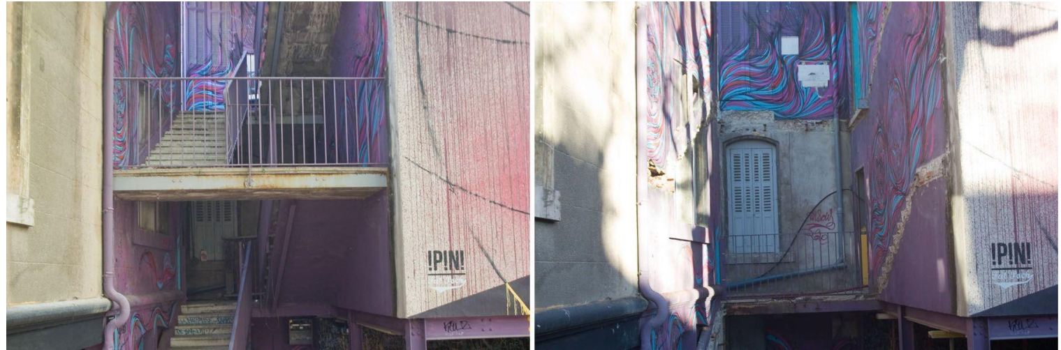
Déconstruction d'un escalier pour réutilisation
